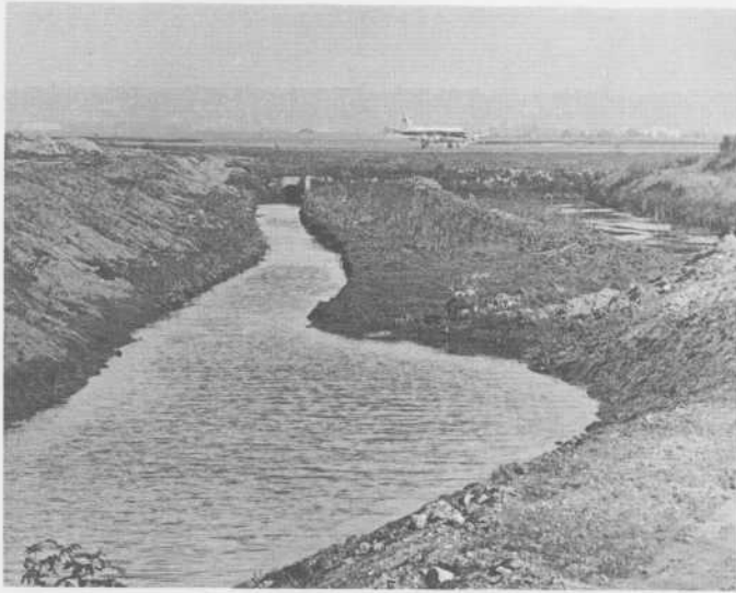
On débarrasse de toute végétation les bassins collecteurs ou réservoirs situés près des aéroports afin de permettre un drainage approprié et de détruire les abris des canards.
